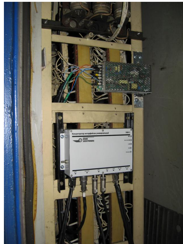
Размещение БЛК в машинном отделении
