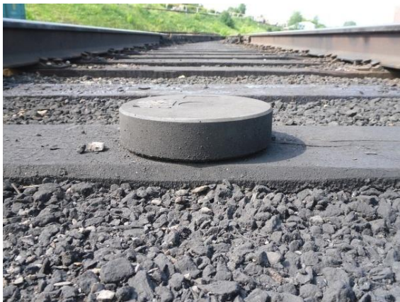
Установка путейых приемответчиков (ППО) на шпалах
